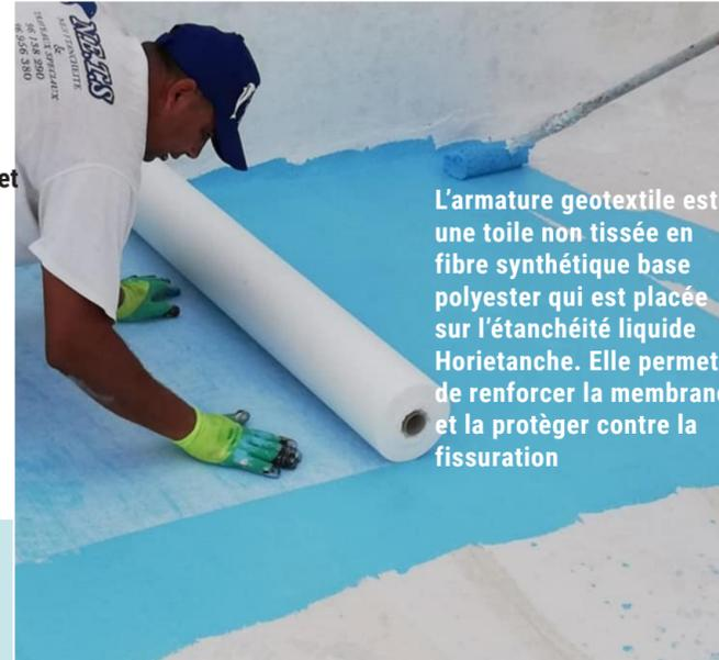
L'armature géotextile est une toile non tissée en fibre synthétique base polyester qui est placée sur l'étanchéité liquide HoriEtanche. Elle permet de renforcer la membrane et la protéger contre la fissuration
